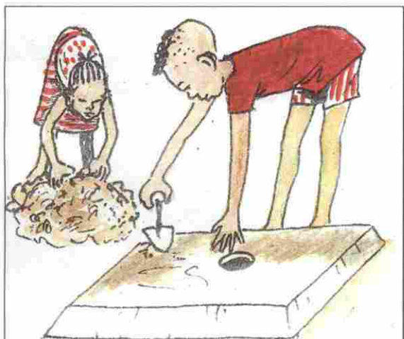
7 - Pôr uma boa camada de argamassa bem comprimida e deixar a abertura central
