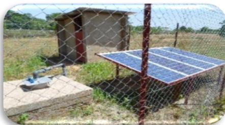
Système de pompage par énergie solaire à Kafigué
