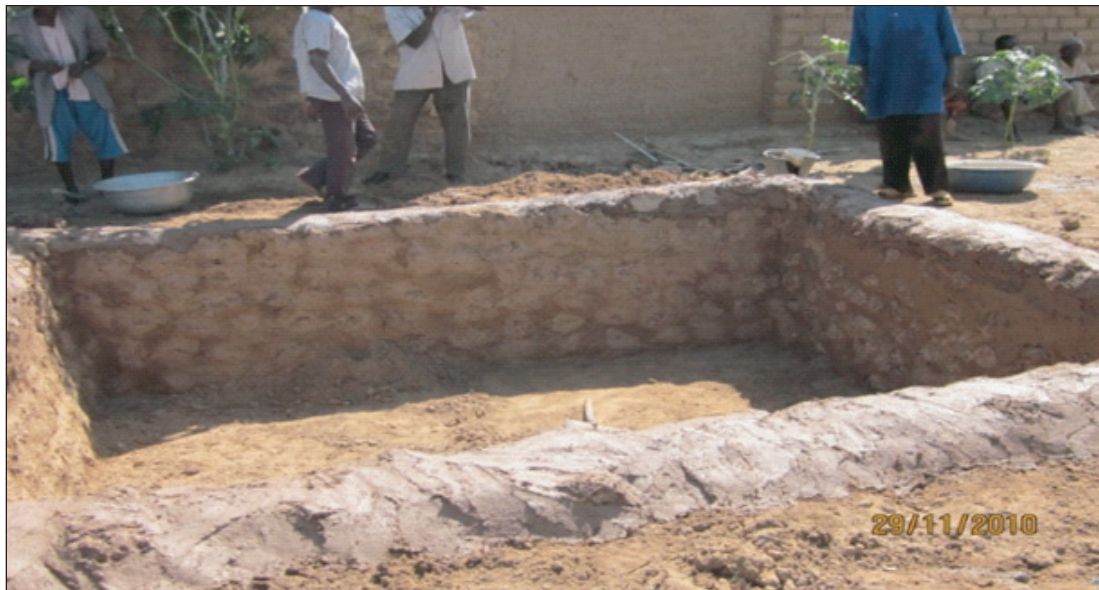
Photo N°4 : Parois et margelle d'une fosse fumière construites avec un mélange de matériaux locaux
