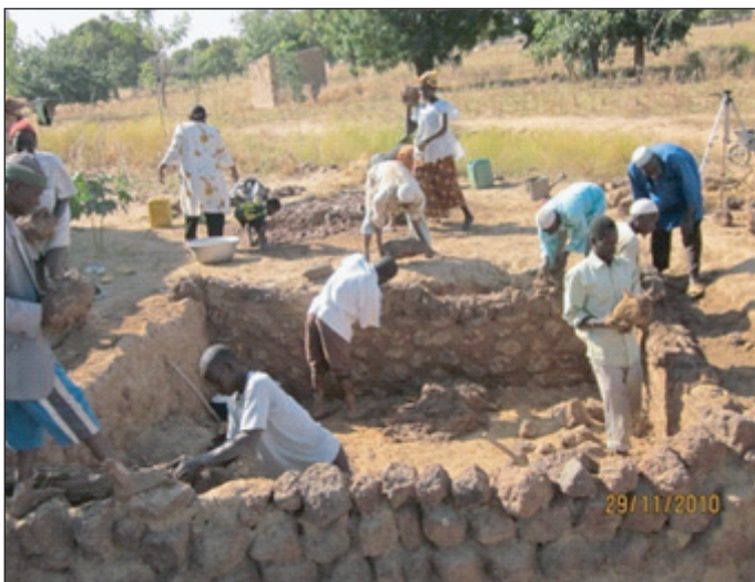
Photo N°4 : Construction de la paroi d'une fosse fumière avec un mélange de matériaux locaux
