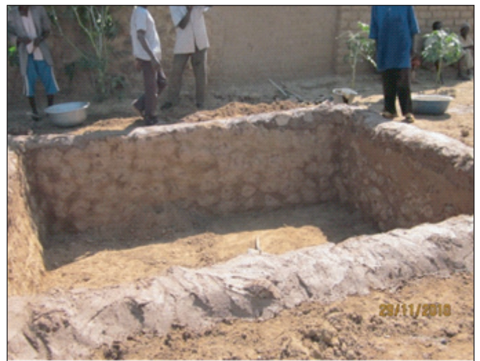
Photo N°5 : Parois et margelle d'une fosse fumière construites avec un mélange de matériaux locaux
