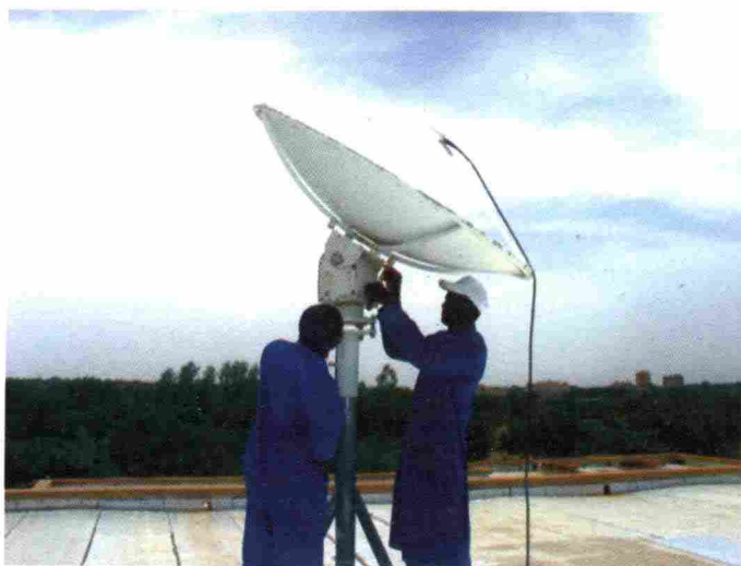
Maintenance de l'antenne de réception du satellite NOAA
