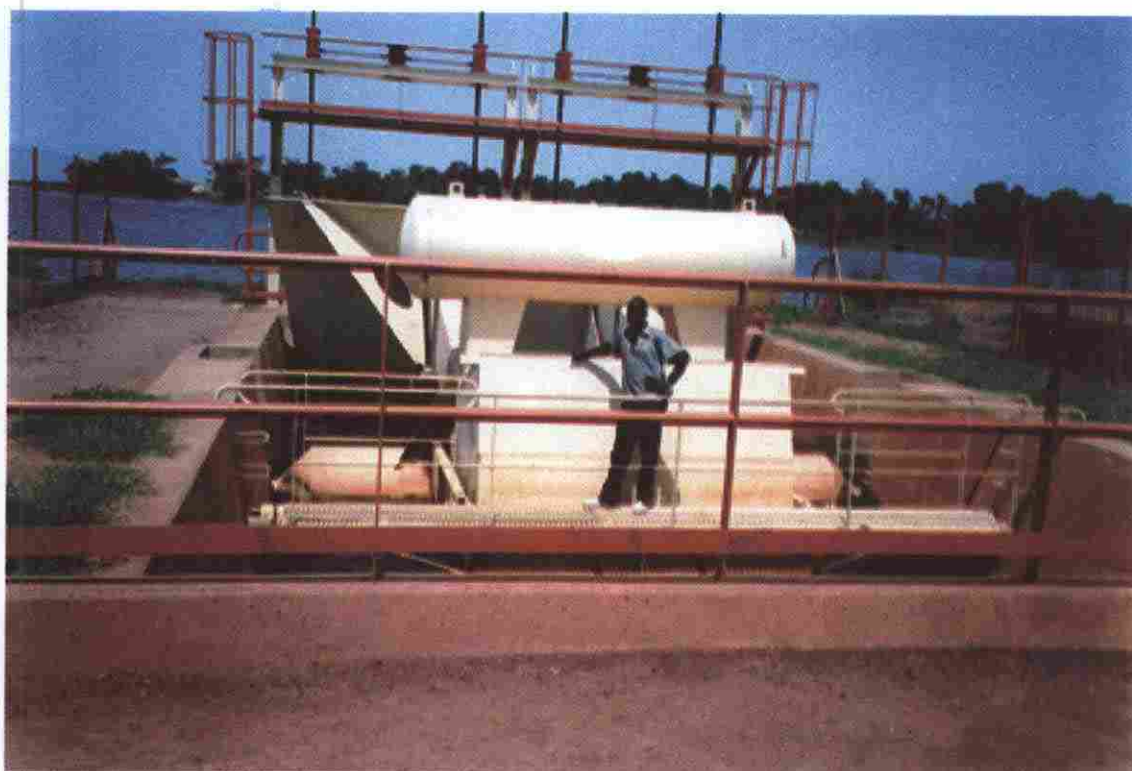
Le régulateur du distributeur de Kokry sur le canal du Macina (Fala de Boki-Wéré) équipé d'une vanne automatique à niveau aval constant type AVIS 280/530 HC avec un débit maximum de 31 m 3 /s. Ce régulateur alimente le casier de Kokry. ( Photo HASSANE, 1999)
