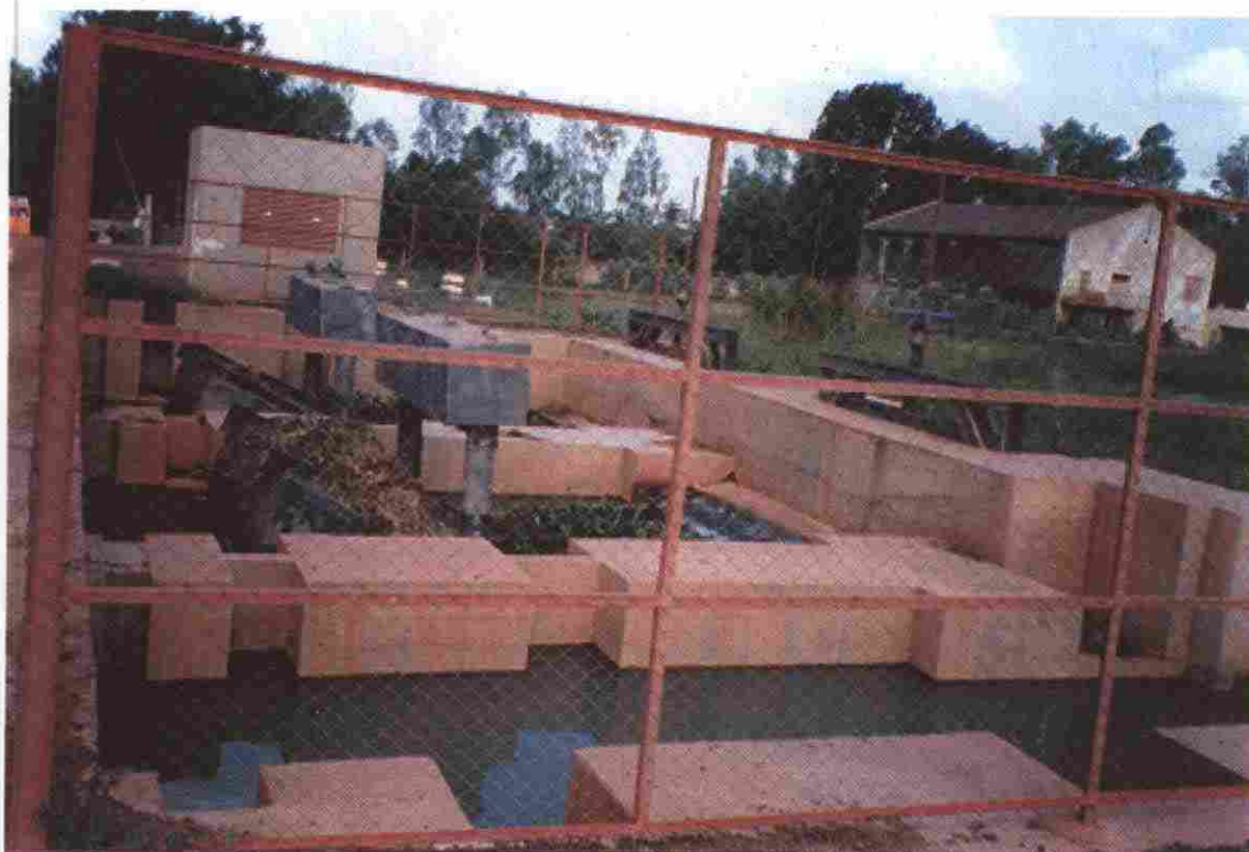
Le régulateur de Niono équipé deux vannes automatiques à niveau aval constant type VANAC 220/800 BC. Ce régulateur alimente le casier Grüber-nord de la zone de Niono et la totalité de la zone de N'Débougou, il n'est pas encore calibré. ( Photo HASSANE, 1999)
