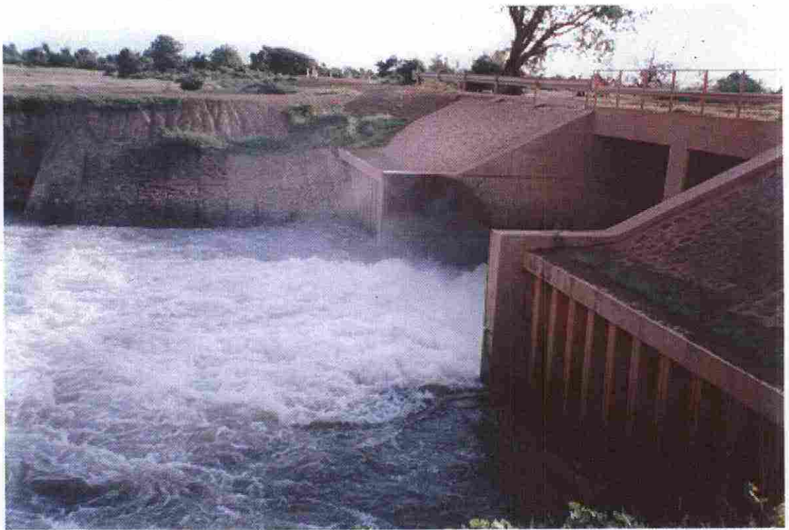
Le déversoir de Kolongo sur le canal du Macina en déversement, il régule le Fala de Boki-Wéré en déversant les eaux excessives directement dans le fleuve. (photo HASSANE A. 02 sept 1999)
