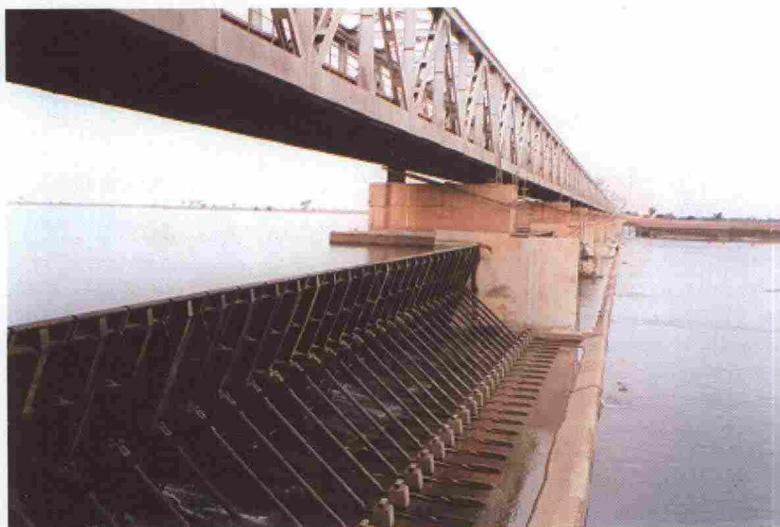
Ci-dessus le barrage de Markala en plein étiage le 16 mars 1999, vue d'une passe et ses vannes à hausses mobiles. Côté amont : 300.23 m repère office (Photo HASSANE A. mars 1999)
