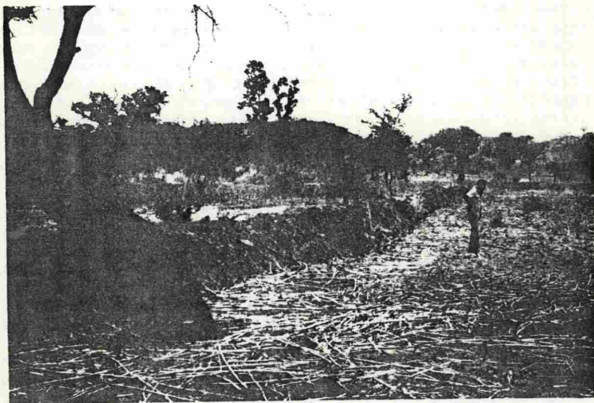
Photo 12 Ravine comblée après deux ans par la digue filtrante et réhabilitation des champs dans la zone d'influence de la digue
