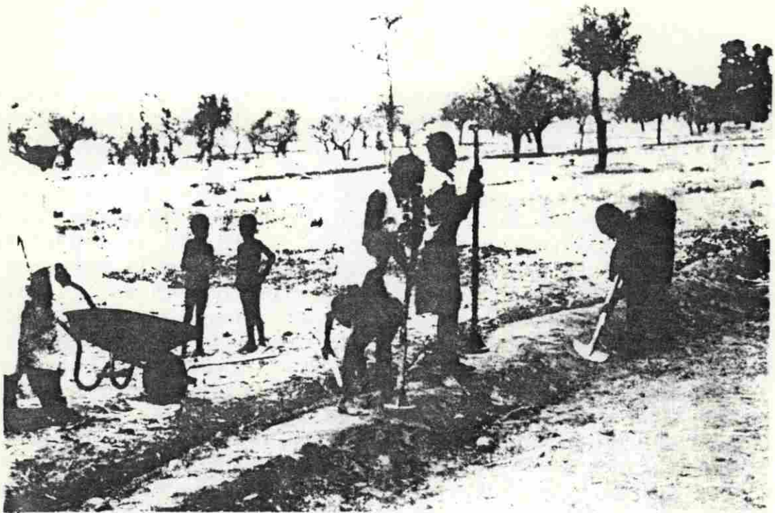
Photo 3 Banquette en construction au Burkina Faso
