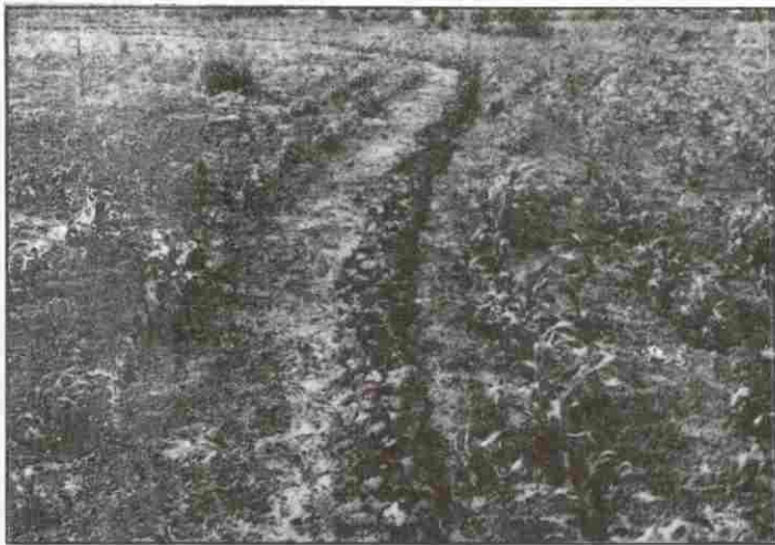
Photo 14 :Diguette sur courbe de niveau et constituée par un entassement de pierres
