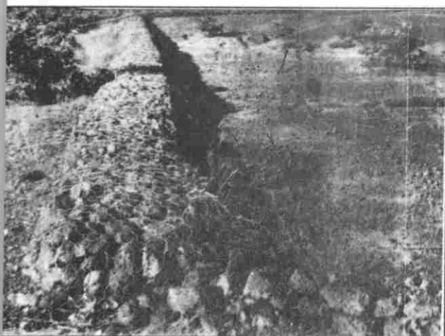
Photo 29 : Digue filtrante en gabions endommagée au milieu. C'est la 2ème digue du traitement de la ravine de Sambtinga.
