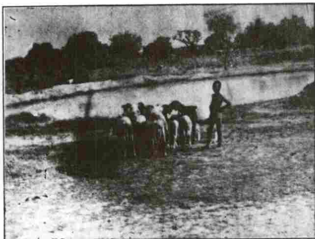
Photo 44 : Un "bouli". La digue constituée par la terre de déblai est en amont en forme de demi-lune (50 m environ). Ces animaux qui viennent de s'abreuver sont en aval , à l'ouverture de la demi-lune 10 m environ)
