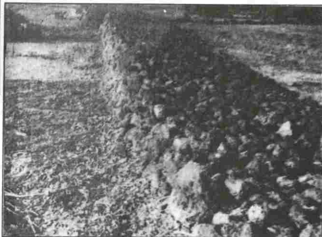
Photo 28 : Vue du mur amont vertical de la même digue filtrante. Remarquez les dépôts
