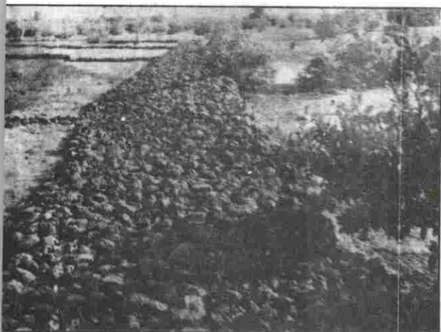
Photo 27 : Digue filtrante en pierres libres avec des liguettes d'épandage à Sambtinga. C'est la 1ère digue de traitement de la ravine de Sambtinga.
